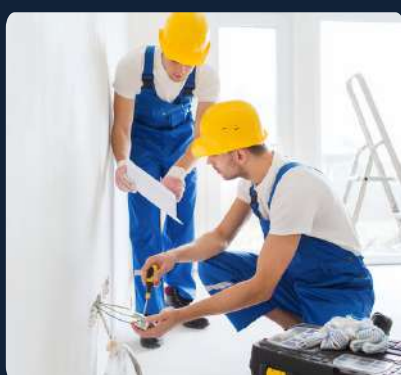
SERVICIO DE ALBAÑILERÍA
